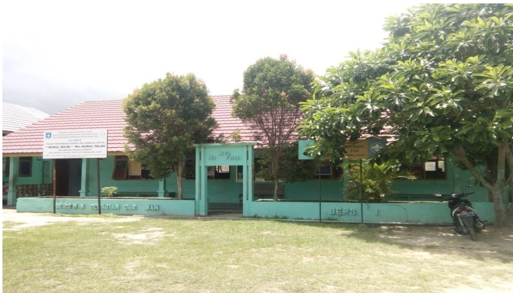
Dokumentasi kondisi gedung bimbingan & konseling MTs. Nurul Falah Air Mesu Timur
