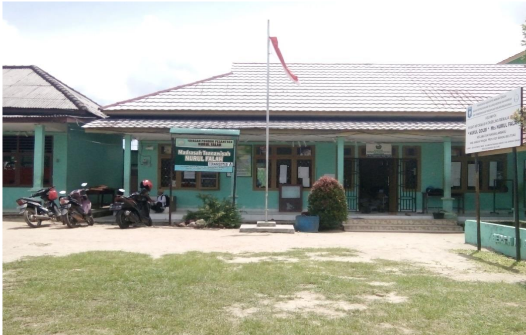
Dokumentasi kondisi gedung kantor/ruang guru di MTs. Nurul Falah Air Mesu Timur
