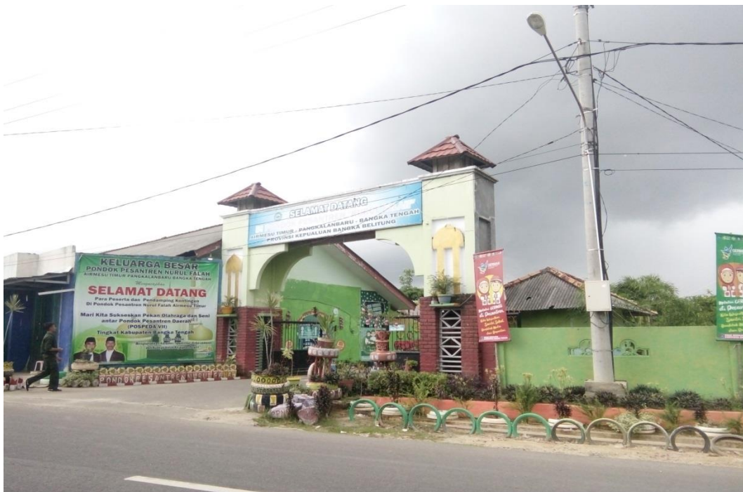
Dokumentasi kondisi Pesantren Nurul Falah Air Mesu Timur (bagian depan)
